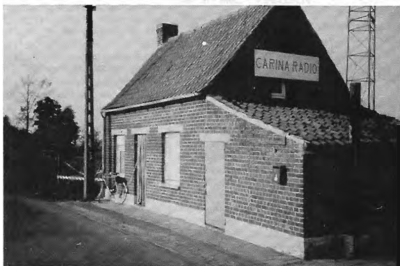
HET STUDIOGEBOUW AAN DE VELDSTRAAT 121 TE ICHEGEM
